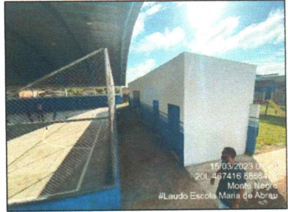
Figura 16 – Vestiários da Quadra Poliesportiva
