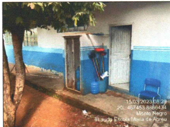
Figura 5 – Abrigo de Gás
