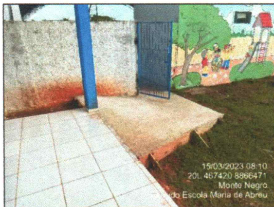
Figura 21 – Rampa de acesso à quadra Poliesportiva
