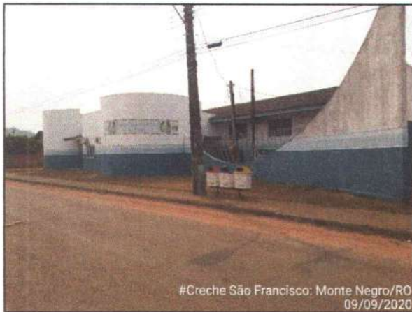
Figura 29: Fachada da Creche São Francisco.
