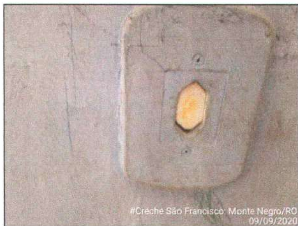
Figura 16: Tomada com dispositivo de proteção instalado de maneira correta.
