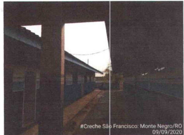
Figura 7: Pátio entre os Bloco 02 e 03.
