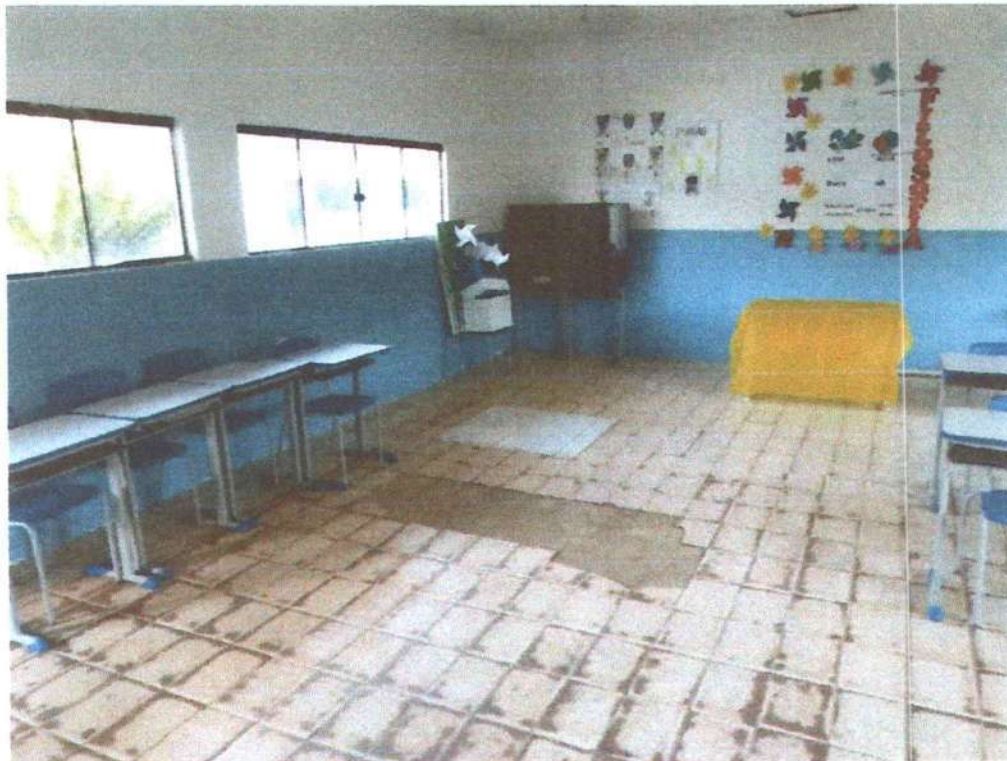
Foto 14 - Vista interna da sala de aula.
