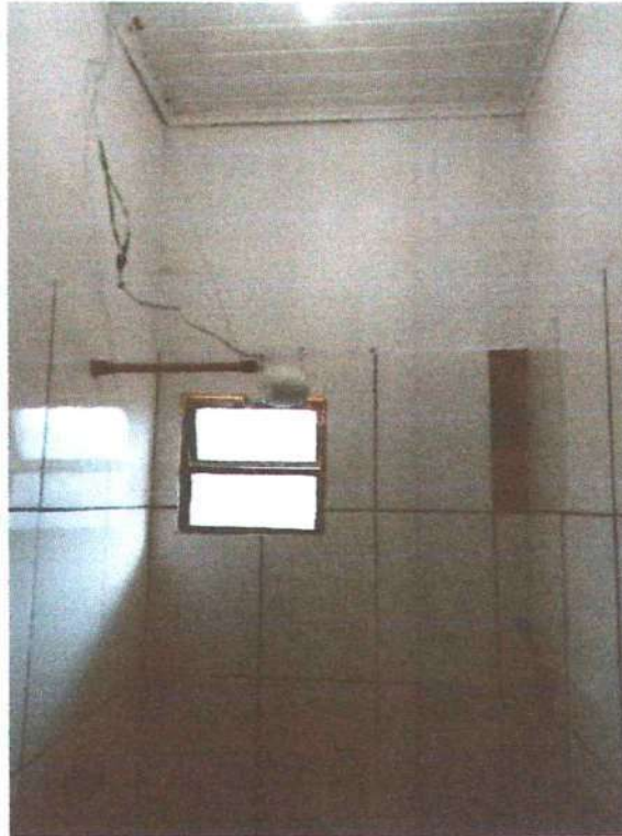
Foto 11 - Vista interna do banheiro da sala dos professores.
