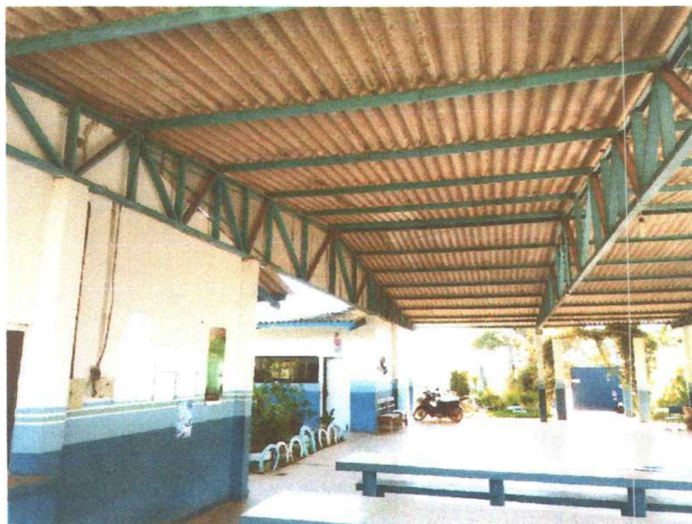
Foto 18 - Vista do pátio.
