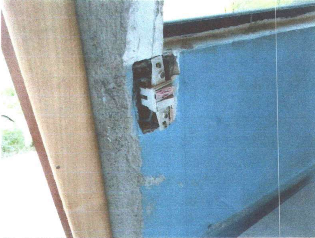
Foto 13 - Vista interna da sala de aula.
