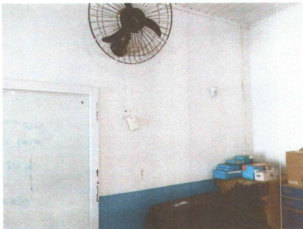
Foto 02 - Vista interna da sala de aula.
