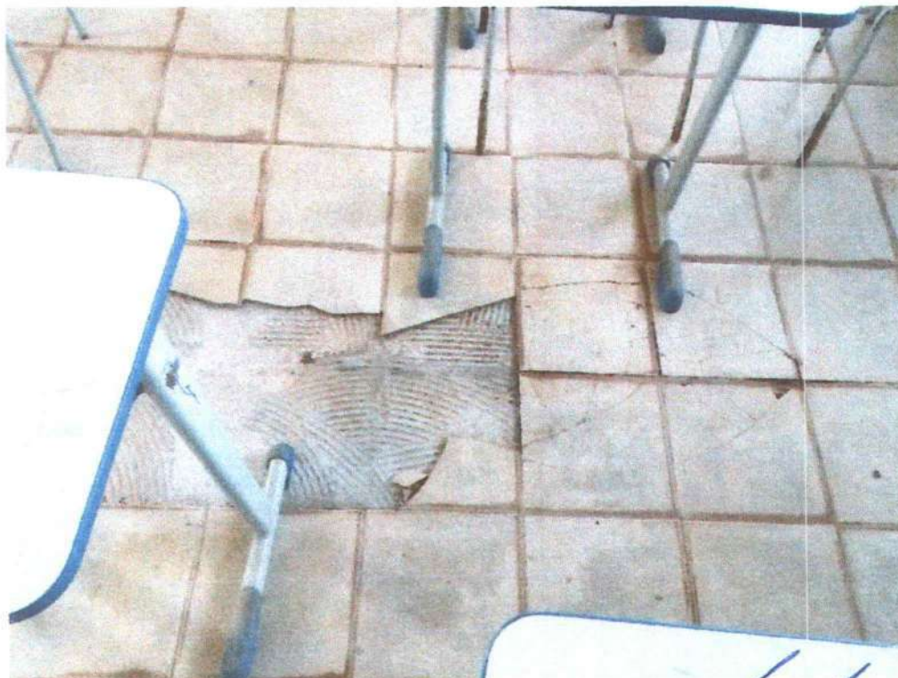
Foto 12 - Vista interna da sala de aula.
