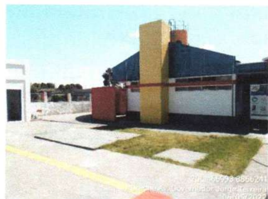
Figura 2: Entrada Principal com Acessibilidade
