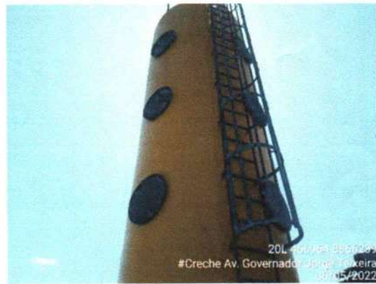
Figura 12: Reservatório d' água metálico.
