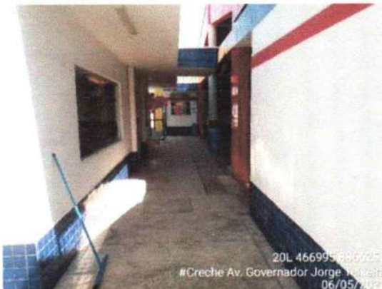
Figura 5: Corredor Lateral com Acessibilidade
