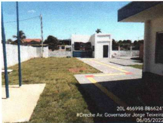
Figura 3: Entrada Principal com Acessibilidade
