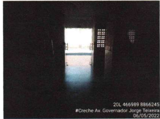
Figura 4: Entrada Principal com Acessibilidade
