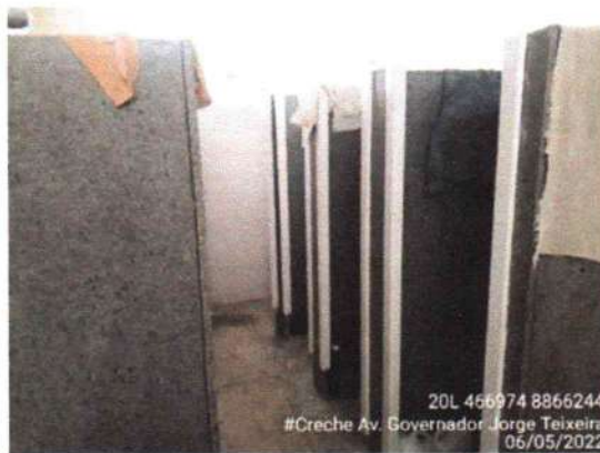
Figura 13: Banheiros em perfeito estado de funcionamento
