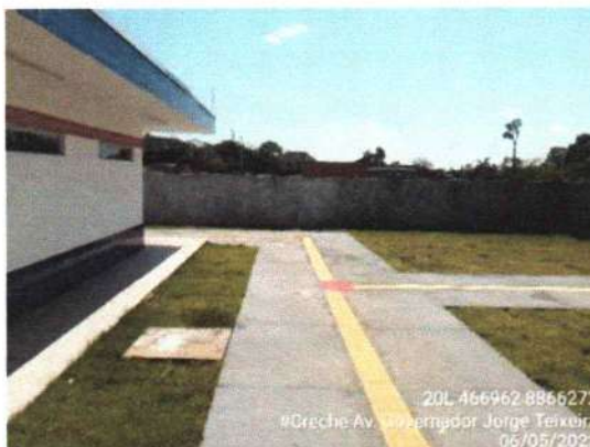
Figura 7: Dois acessos em calçadas com Acessibilidade ao fundo
