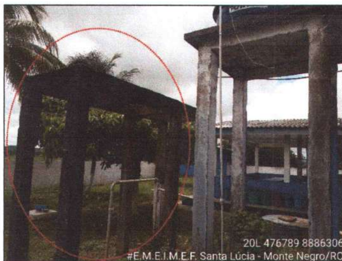
Figura 13: Suporte de Reservatório d' água a ser Demolido (em vermelho)
