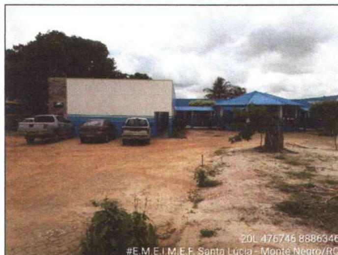
Figura 6: Vista Geral dos Blocos da Escola Santa Lúcia
