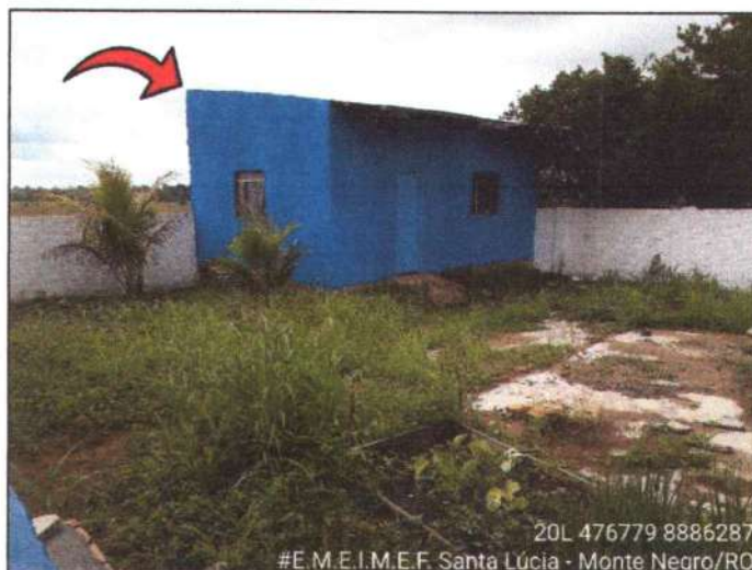
Figura 8: Depósito em alvenaria ao fundo da Escola
