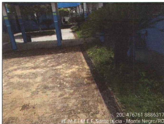
Figura 15: Pátio descoberto com Canaleta e grelha para água pluvial
