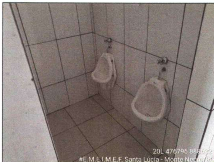
Figura 18: Mictório dos Banheiro Masculinos
